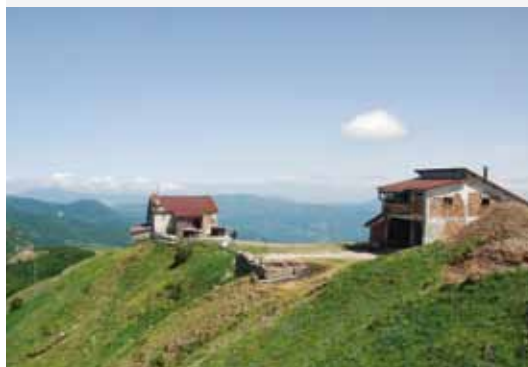
La vecchia stazione della bidonvia sul Monte Bue
