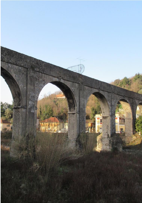
Ponte Sifone sul Torrente Geirato
