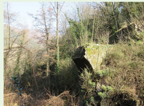
Resti del Ponte Ronco
