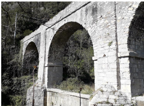
Ponte Canale sul Torrente Geirato
