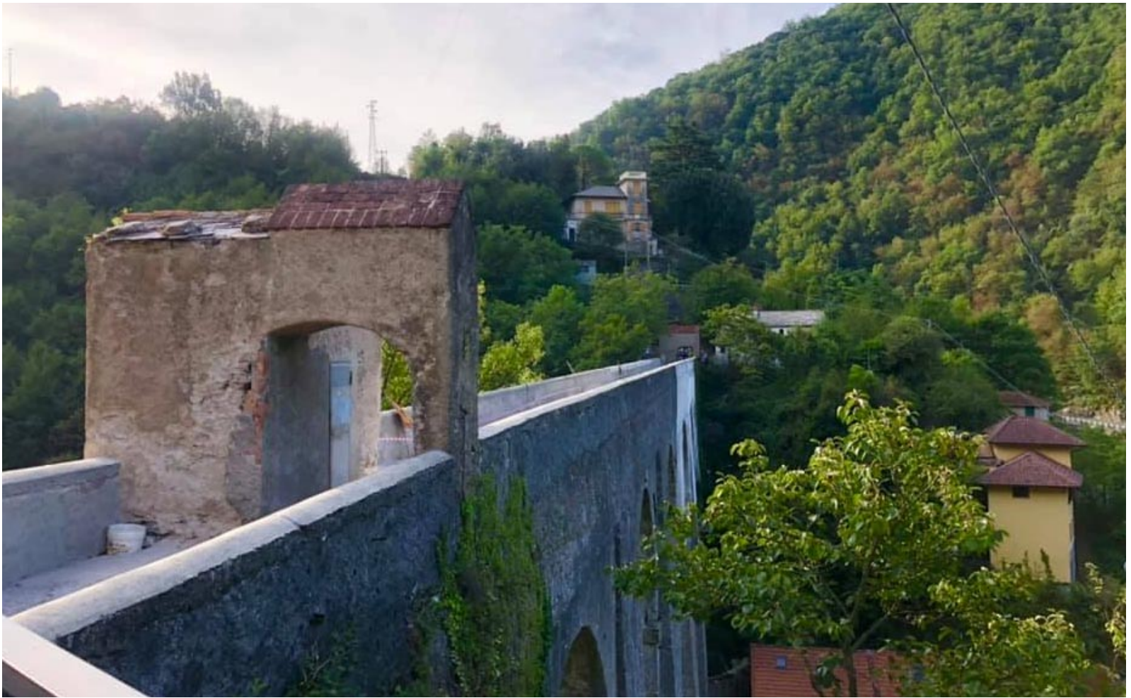
Porte per accedere al Ponte di Cavassolo
