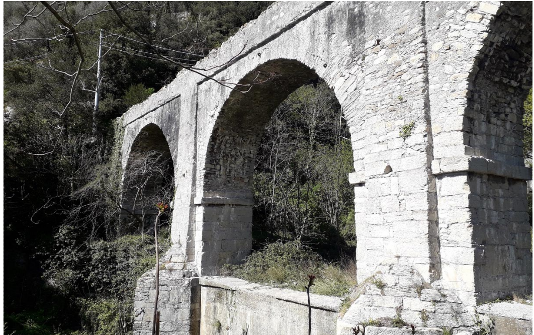
Ponte Canale sul torrente Geirato
