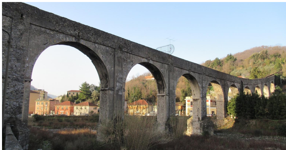
Ponte Sifone sul torrente Geirato
